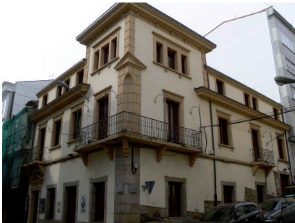
Fig. 1 Edificio de la antigua Cámara de Comercio de Ferrol. Foto: A. Malde.
