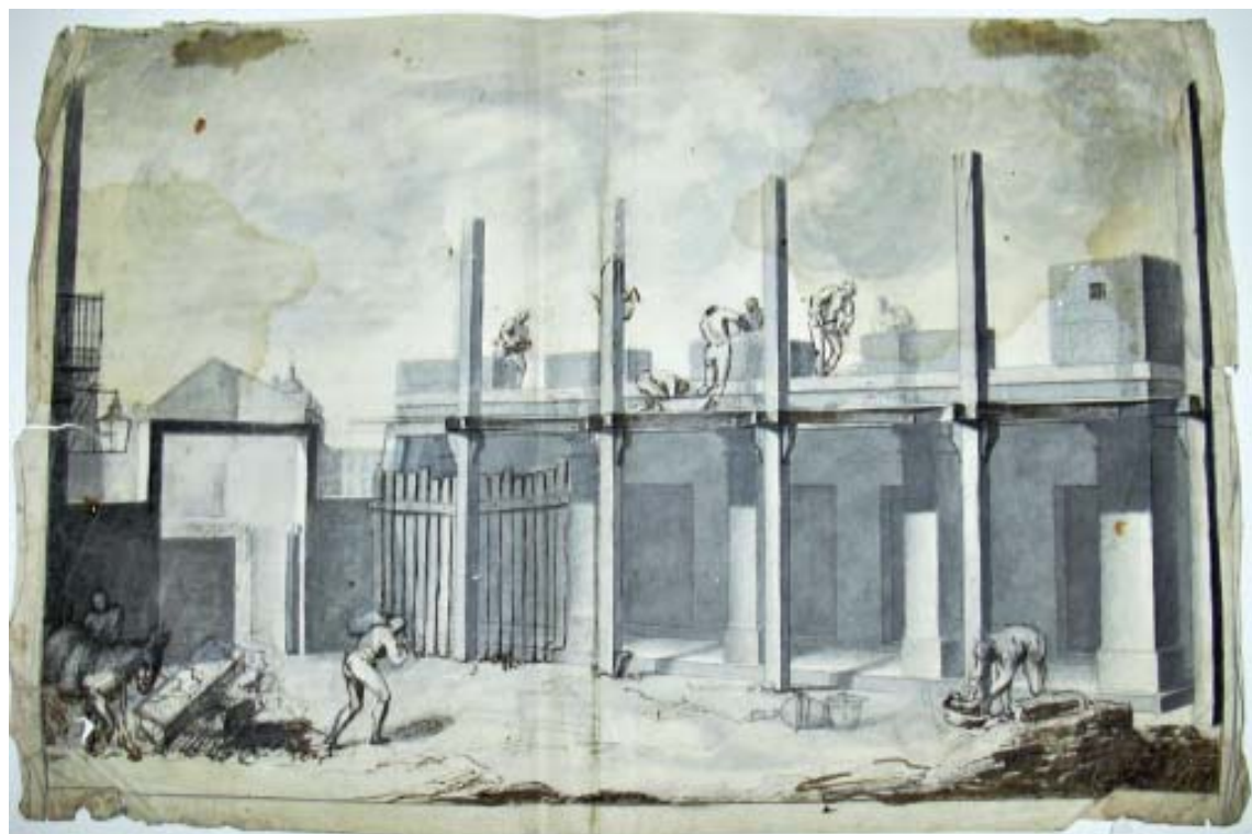
Fig. 18.- Perspectiva de un andamio.
