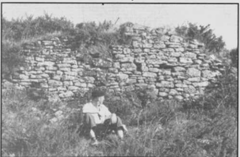
VII-1954.- Parapetos externos desde el camino de A Cabana.
