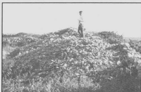
VII-1954.- Gran amontonamiento de cascotes en la parte de la muralla llamada A Torre.
