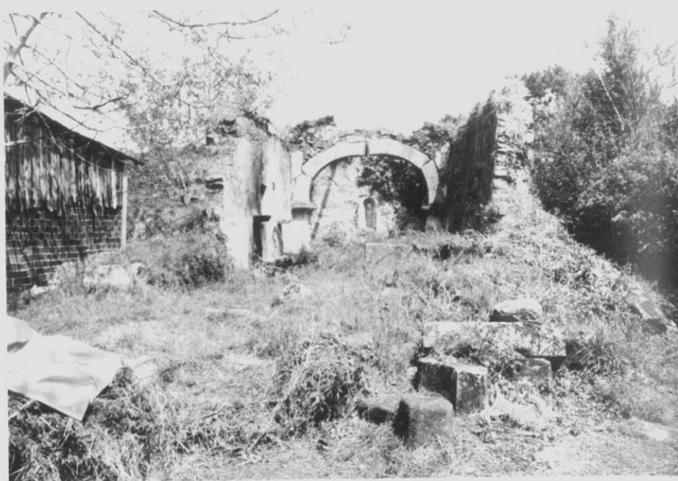
Estado actual de la capilla de San Paio.
