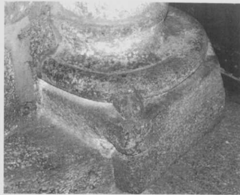
Fig. 4.- Santiago de Reboredo. Basa sur del arco triunfal.
