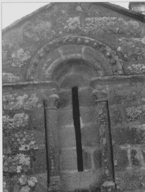
Foto 5: Ventana del exterior del ábside (Foto del autor).
