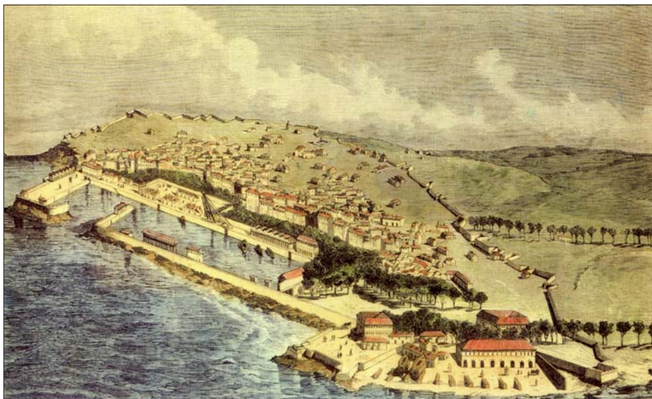
Vista de época del Arsenal de Ferrol. En primer término, frente a las gradas de construcción de buques, aparece la amplia Sala de Gálibos donde estuvieron alojados los jesuitas.
