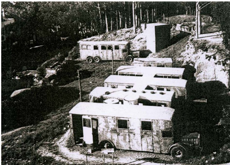
3. Restos de los camiones alemanes estacionados en el monte de Santa Margarita, en el terreno situado frente al nº 10-12 de la calle Padre Sarmiento, a espaldas de los inmuebles nº 129-131 y nº 133 de la avenida de Finisterre (Foto A. Martí).
