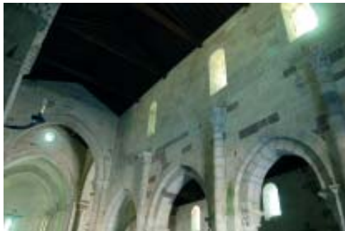
Fig. 2. Rates. Vista de la nave central.
