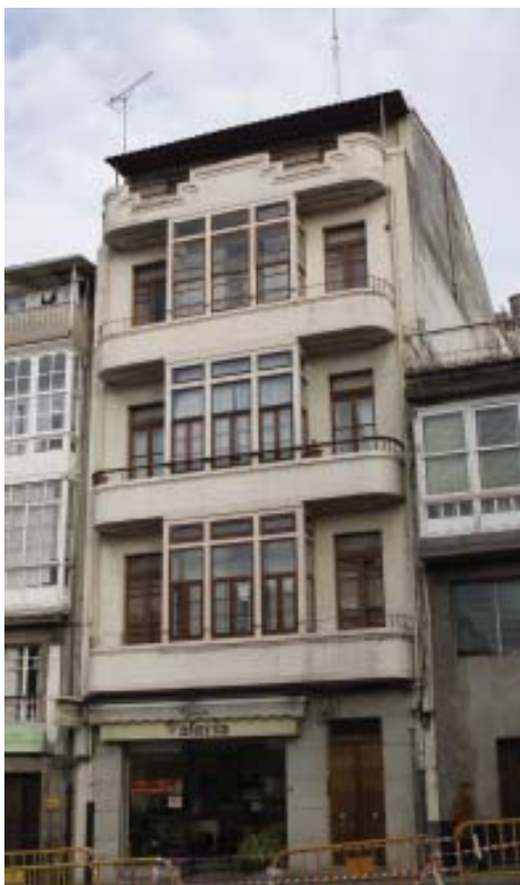
Figura 4. Edificio de viviendas en rúa Valdoncel, 14, Betanzos.
