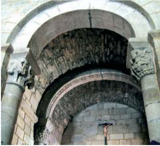
Fig. 22.- Santa María de Tomiño. Interior de los arcos y bóveda del presbiterio.
