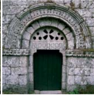
Fig. 14.- Santa María das Junias. Arquivoltas y tímpano de la puerta principal.
