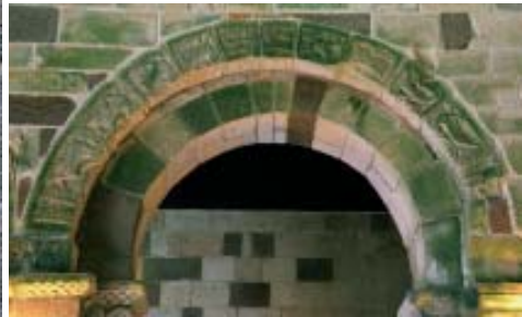
Fig. 10.- San Pedro de Rates. Arco fornero de la nave norte.
