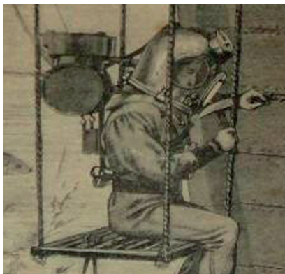
(Fig. 2) Imaxe que aparece en Manual for divers and Diving operations. Siebe Gorman & Co. 1895. Apréciase o peso que colga do tanque e o pico que utiliza para reparar o barco.
