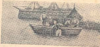
Operaciones preparatorias para el descenso de los buques
