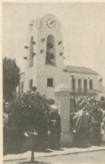
Bellas Artes argentino. — Torre del Palacio Municipal de Montevideo (Uruguay), una de las más grandes obras arquitectónicas del Norte argentino.
