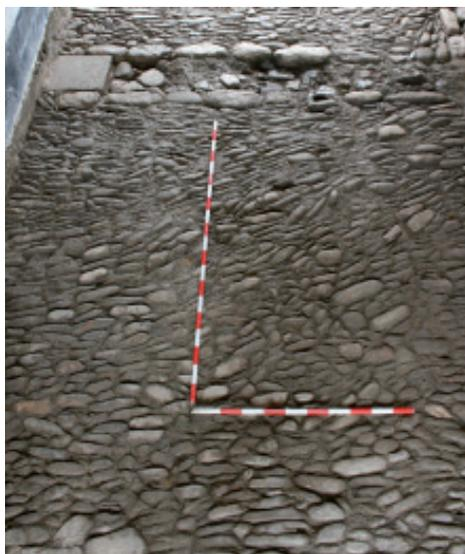
Fig. 6: Detalle do piso de circulación empedrado na sala de entrada da *Porta dos Carros*.
