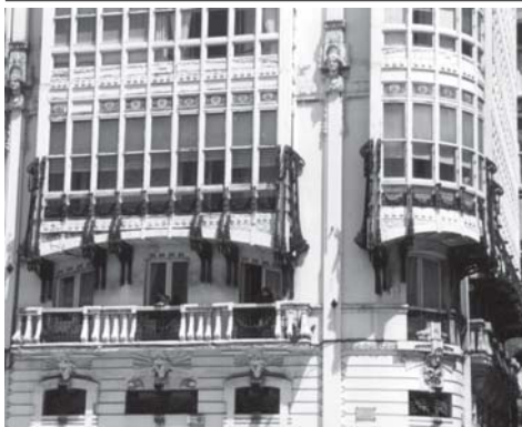
fig. 13.- Detalle de la Casa Rey.
