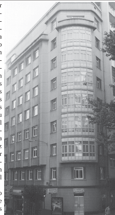
fig. 46.- Cierre de las terrazas con una galería en la década de los noventa. Edificio de la Avenida de Arteijo, 11. Arquitecto: Peregrín Estellés Estellés. 1957.
