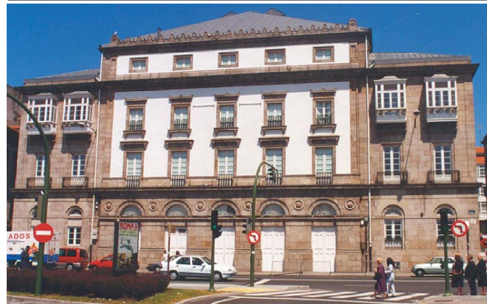
fig. 43.- Fachada posterior del Teatro Principal (hoy Teatro Rosalía de Castro y Biblioteca de la Diputación Provincial). Arquitecto: Faustino Domínguez Coumes-Gay. Rehabilitación en la década de los ochenta por el arquitecto provincial Fernando Cebrian del Moral, y en los noventa por Manuel Gallego Jorreto.
