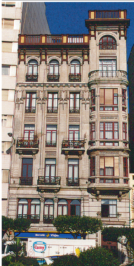
fig. 16.- Casa Iglesias. Avenida Linares Rivas, 16. Arquitecto: Pedro Mariño. 1926.
