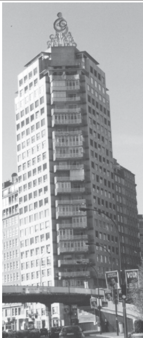
fig. 45.- Aspecto de un edificio modificado por el uso de los propietarios.
