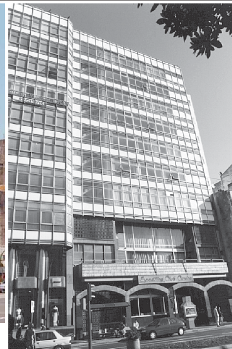
fig. 28.- Edificio del Casino. Avenida de la Marina y calle Real. Arquitecto: Andrés Fernández-Albalat. 1969.
