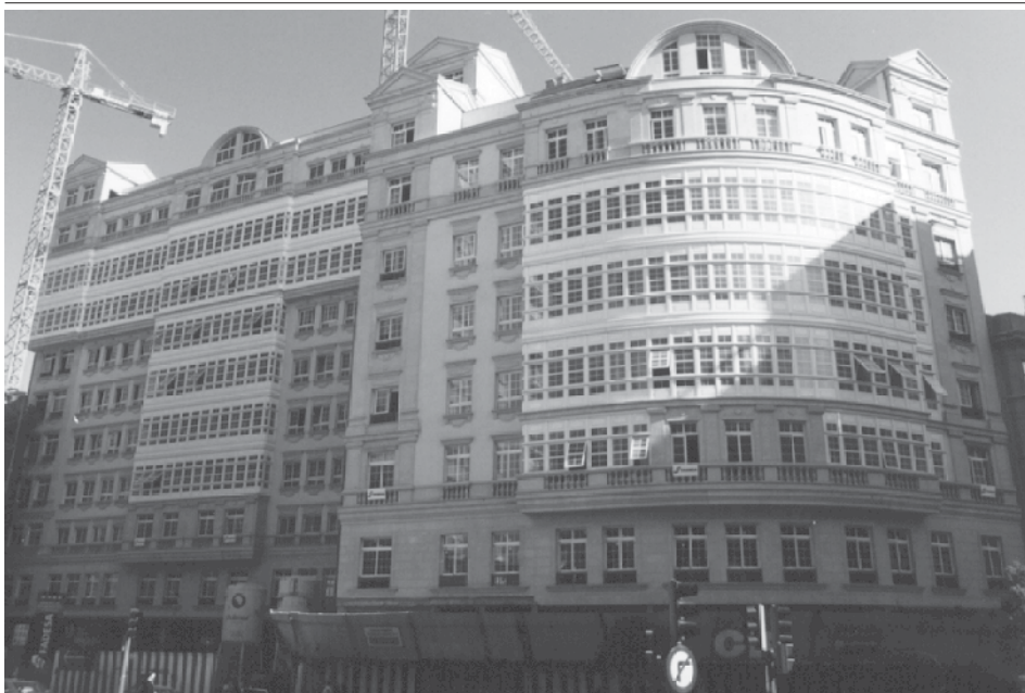
fig. 33.- Edificio Conde de Fenosa. Calle Fernando Macías. Arquitectos: Antonio de la Morena Pardo y Joaquín Sanjuán Martín. 1997.
