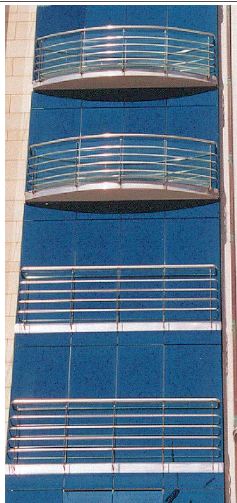
fig. 38.- Detalle del edificio de la Optica Americana.
