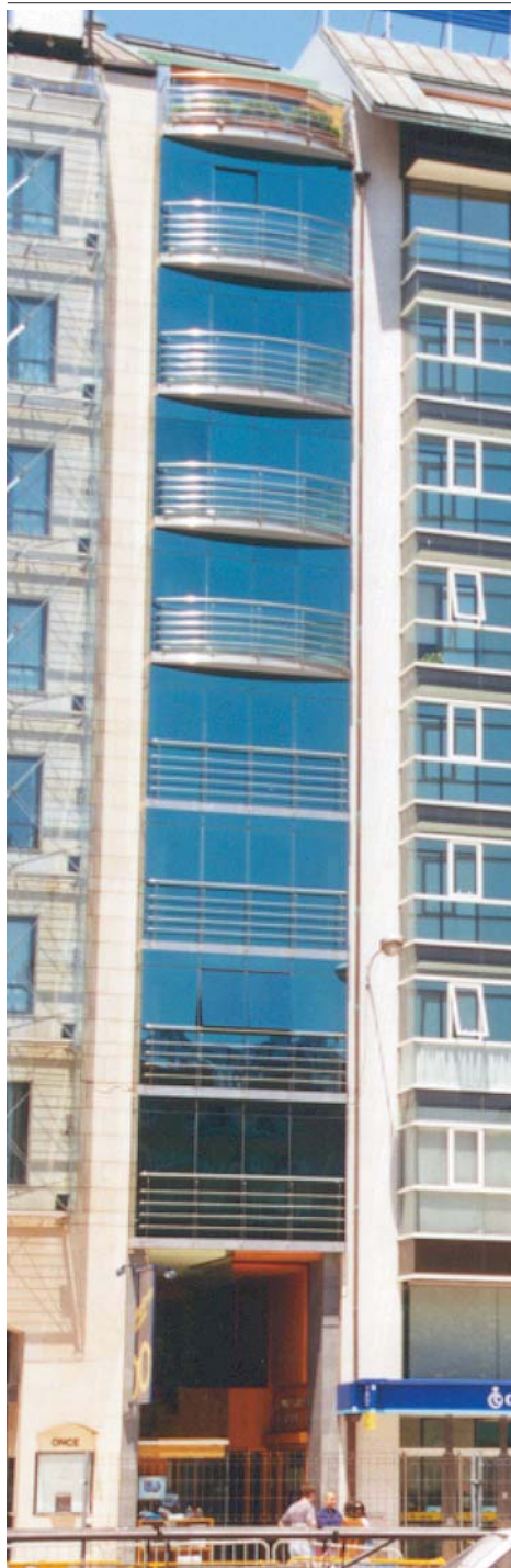
fig. 37.- Edificio de la Optica Americana. Arquitecto: Alvaro Romero.
