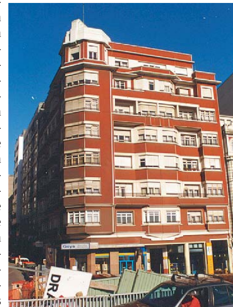
fig. 24.- Casa Losada. Avenida Linares Rivas, 57-59. A Coruña. Arquitecto: Peregrín Estellés Estellés. 1937.
