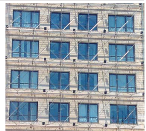
fig. 36.- Detalle del edificio de la Fundación O.N.C.E.
