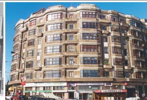
fig. 23.- Conjunto de edificios en la calle Ramón de la Sagra. Arquitecto: Rafael González Villar. 1939.
