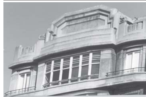
fig. 22.- Detalle de la coronación Déco del edificio del Cine Avenida.
