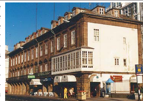
fig. 44.- Adición de una galería en las Casas de Paredes del siglo XVIII.
