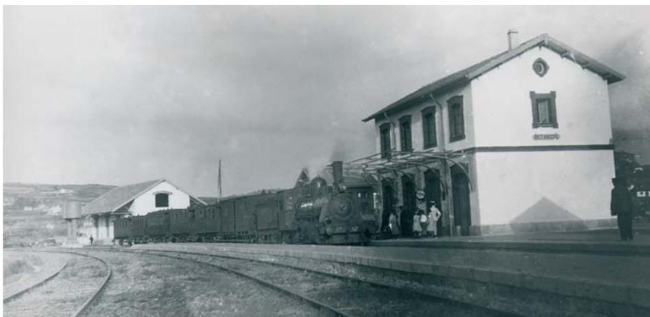
*Estación Betanzos-Pueblo en la década de 1920. Tren correo en dirección A Coruña arrastrado por la locomotora 120-2131 o 2132, construida por Esslingen (Alemania) en 1884. Coches de madera de dos ejes, contruidos por Alsbury's (Manchester) en 1886.*
