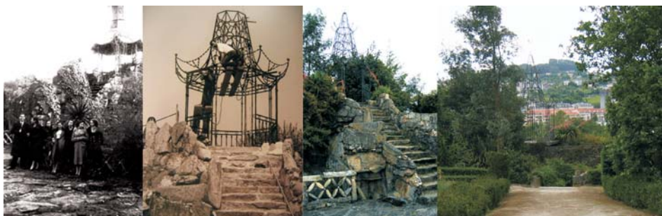
Figura 22. Reconstrucción de mirador de hierro.
