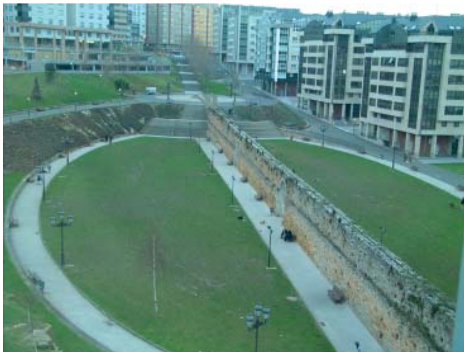
Panorámica del acueducto mandado construir por el Intendente Caballero en A Coruña (1721). Foto de José Castro (FLIRK).
