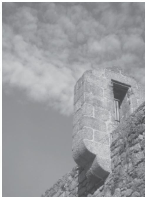
Acueducto en el coruñés Paseo de los Puentes. Detalle constructivo. Foto de Neicher (FLIRK).
