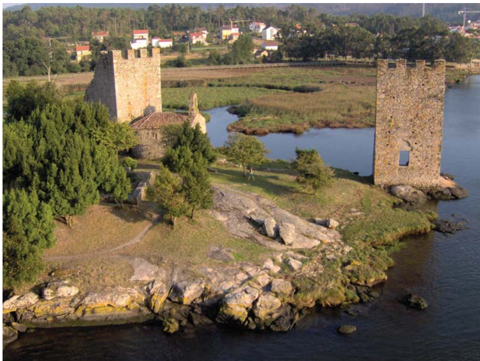
Fig 4.- Vista de las «Torres de Oeste» de Catoira (Pontevedra).
