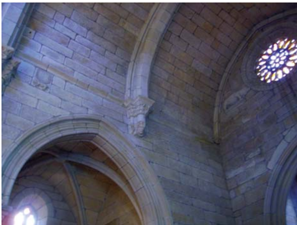
Fig. 6.- apoyo del arco fajón del brazo sur del crucero.
