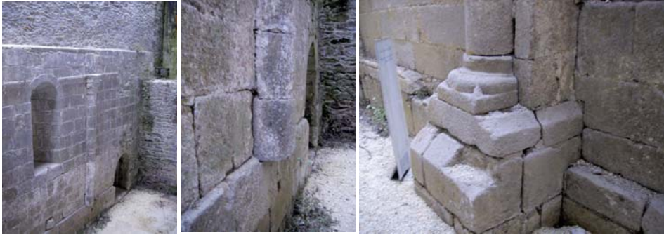
Fig. 23, 24 y 25. Monasterio de Monfero. Detalles de semicolumnas de los restos del siglo XII.
