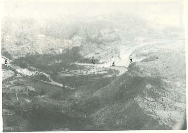
FIG. 434 CONTRAEMBALSE DE LAS BARIAS (1) que represa las aguas del Nizao turbinadas por la H. E. de Valdesia a las horas pico (2), de modo que puedan ser liberadas para riego de acuerdo al horario campesino. La toma de agua del "Canal Marcos A. Cabral" (3) está inmediatamente después del Contraembalse, que tiene un "terraplén hormigonado" (4) para evitar el ocasional desbord de las aguas. Foto: INDRHI.
