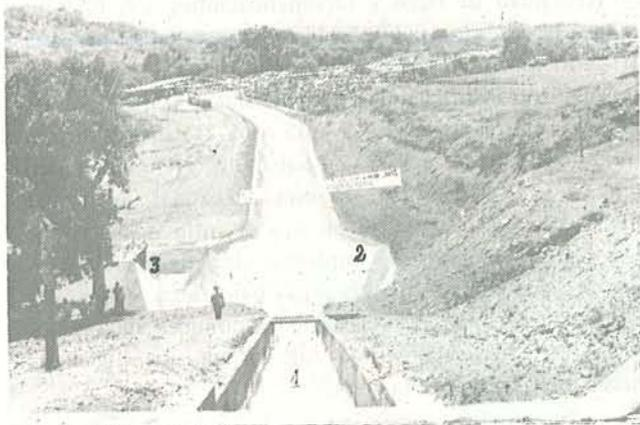
**FIG. 467 PRINCIPIO DEL CANAL PRINCIPAL.** El agua tiene una caída de 59 m (1), y su ímpetu es amortiguado por la "tina de disipación" (2) —que se ve completada por un "canal de descarga" (3) para cuando haya caudales extraordinarios—, antes de continuar por el "canal principal". Foto: INDRHI.
