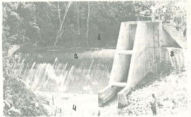
**FIG. 466 TOMA DEL CANAL.** Al río San Juan (1) se le construyó una Presa de Derivación (2) con una altura suficiente para garantizar en todo tiempo el caudal mínimo del canal. El agua es desviada por la compuerta de regulación (3), y el excedente del agua sigue río abajo (4). Foto: INDRHI.
