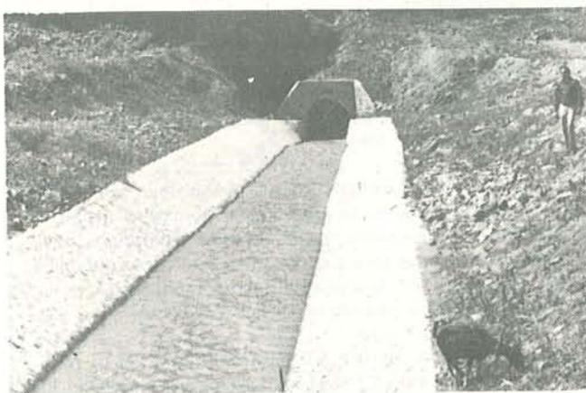
**FIG. 469 ENTRADA AL TUNEL DE 2.3 KMS,** y que economiza 26 kms de canal de conducción. El túnel tiene una anchura de 2.9 m. Foto: INDRHI.
