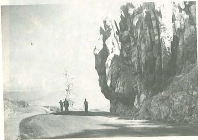
**FIG. 37 FRACTURAMIENTO VERTICAL EN ROCAS VOLCANICAS** de la carretera Valle Nuevo—Constanza, próximas al Convento. Foto: BUENO TORRES, S.
